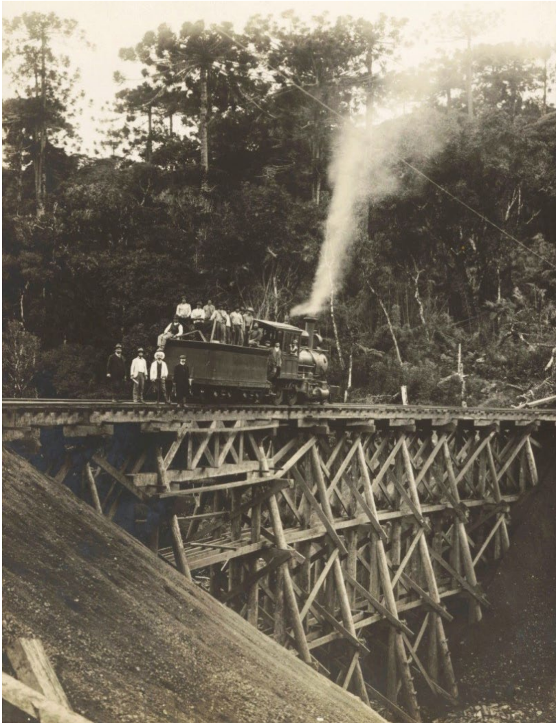
Próba wytrzymałości mostu na trasie kolei Parana – Santa Catarina (zdjęcie z archiwum T. Wierzbowskiego udostępnione dzięki uprzejmości J. Łuka).
